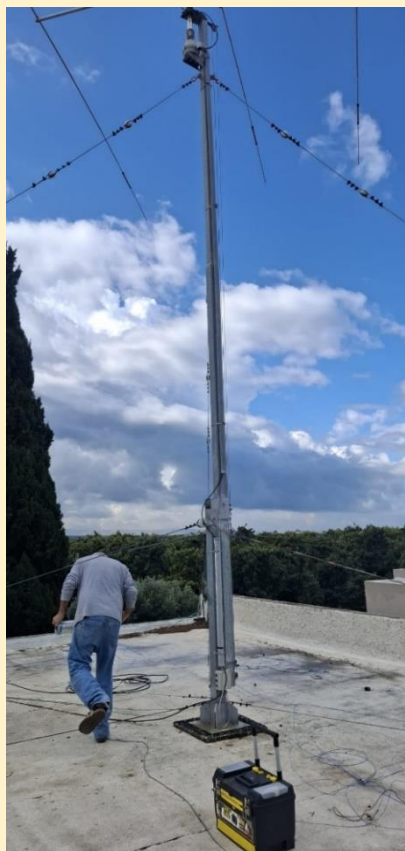
האנטנה לפני הפירוק
