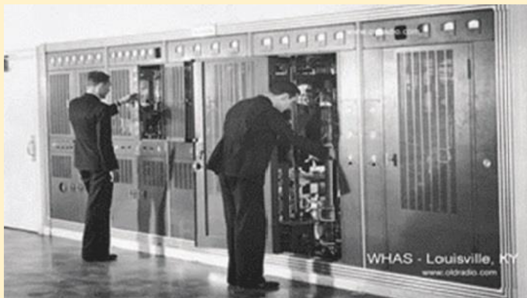
תחנת רדיו AM מסחרית משנת 1938 עם מגבר דוהרטי 50 kW [9]
