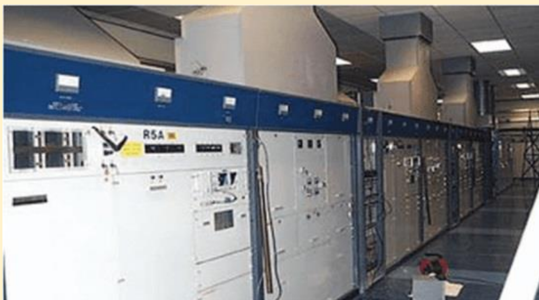
תחנת רדיו AM מסחרית משנת 1978 עם מגבר דוהרטי 150kW [9]
