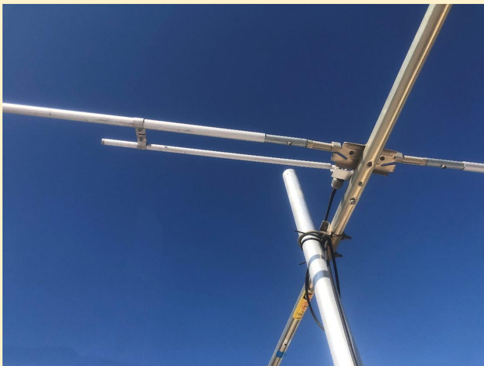
איור 3 – מתאם הגמא לאחר הבנייה
